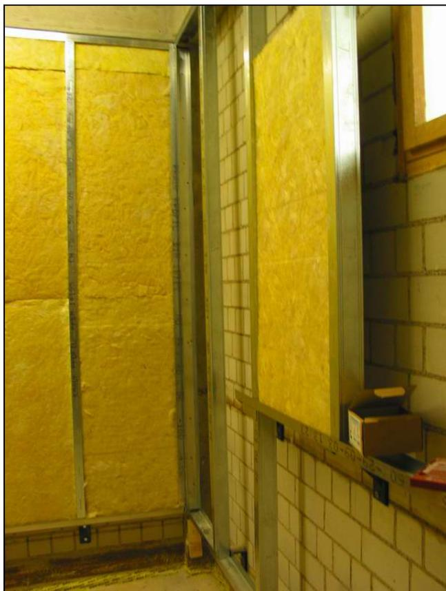
**Abbildung 78 Unterkonstruktion für Vorsatzschale im Senderraum**
