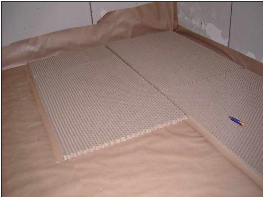
**Abbildung 18 Pappwaben auf Rieselschutzfolie**
