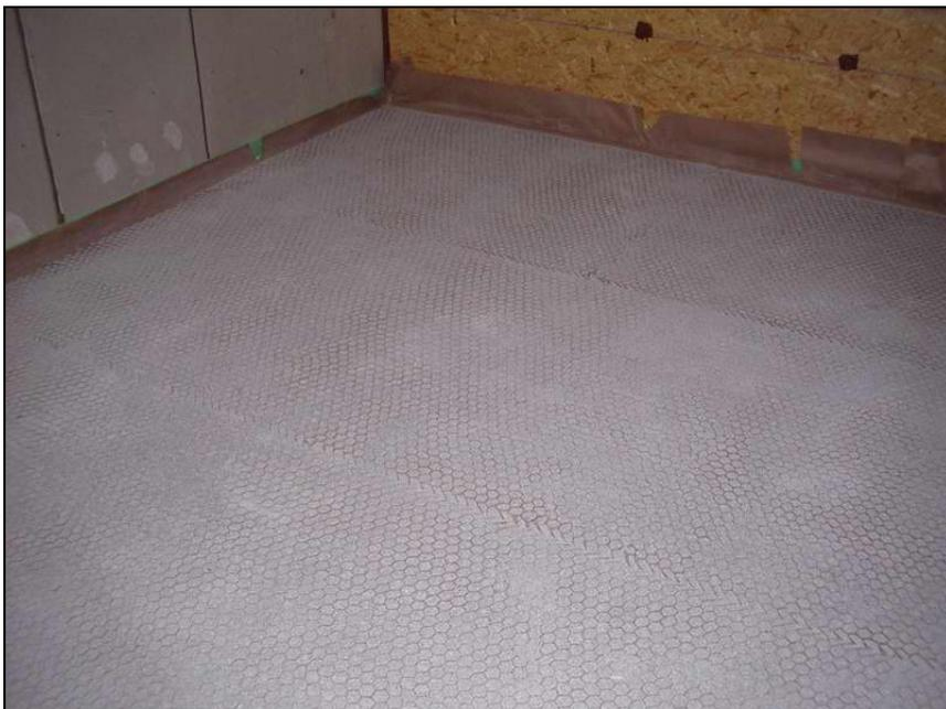
**Abbildung 19 fertige Rohdeckenbeschwerung**
