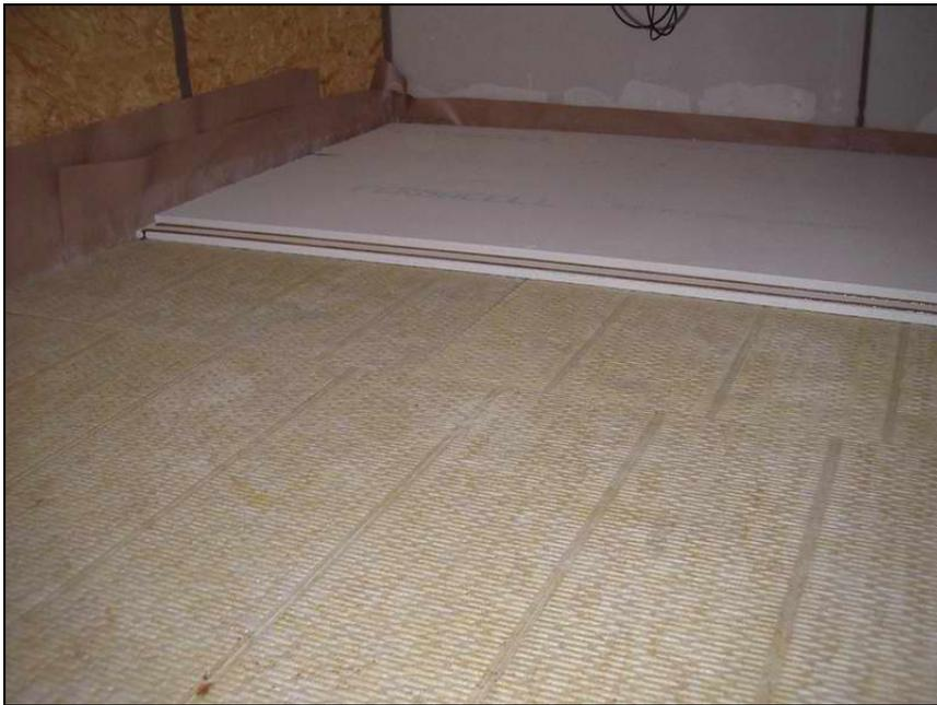
**Abbildung 16 Verlegung des Fermacell 2E22-Estrich-Elementes auf der Trittschalldämmung, Stufenfalz mit doppelter PU-Kleber-Spur**
