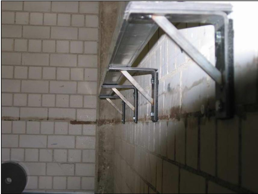
**Abbildung 76 Konsolen für die Vorsatzschale im Senderraum**
