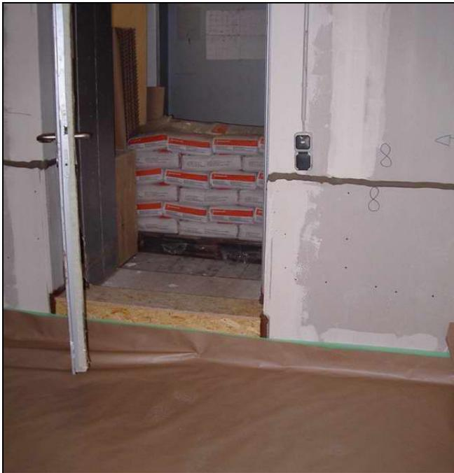
**Abbildung 20** Bereitstellung der Schüttung in Säcken
