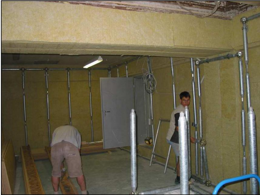
**Abbildung 80 Unterkonstruktion für Vorsatzschale im Empfangsraum, abgedämmter Baukörper**
