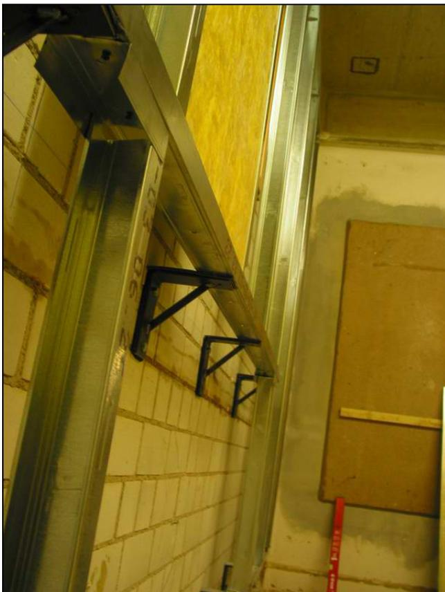
**Abbildung 77 Unterkonstruktion für Vorsatzschale im Senderraum**
